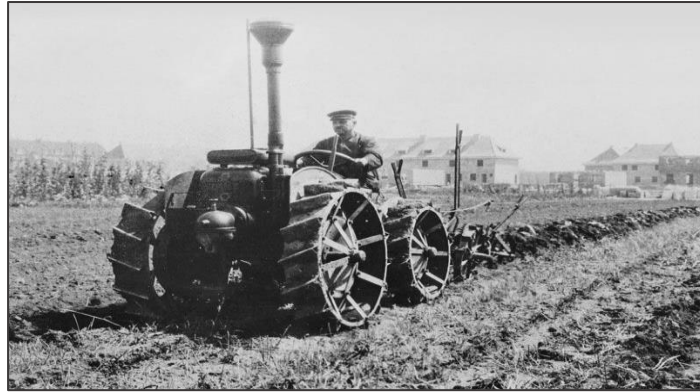
Obr. 5 Prvý traktor typu LANZ HP s kĺbovým riadením a ovládaním pohonu všetkých kolies – rok 1923
