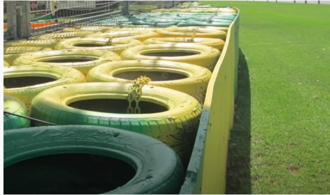
Obr. 19 Stena z pneumatík s obalom
