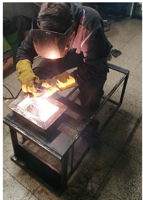
Obr. 13 Zváranie základne pre motor
