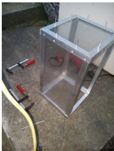
Príloha C - Obr. 7 Kryt v priebehu stavby [Jozef Nemčík – 15.10.2017]
