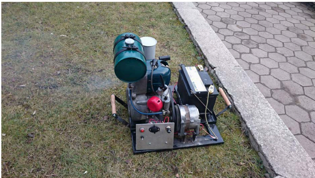
Kompletná funkčná elektrocentrála v prevádzke.
