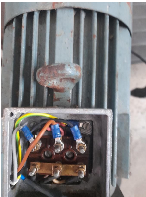
Zapojenie elektromotora (Zdroj, Kopko, L., 2023 )
