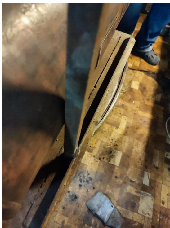
Zváranie štvorhrannej rúrky ku vzdušníku (Zdroj, Kopko, L., 2023 )
