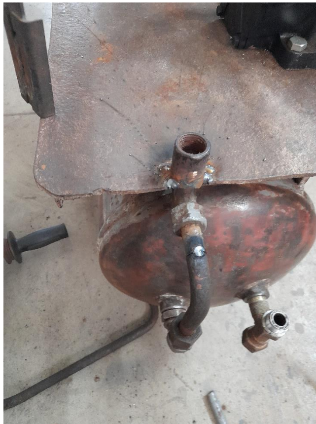
Zváranie výstupu na tlakový spínač (Zdroj, Kopko, L., 2023)
